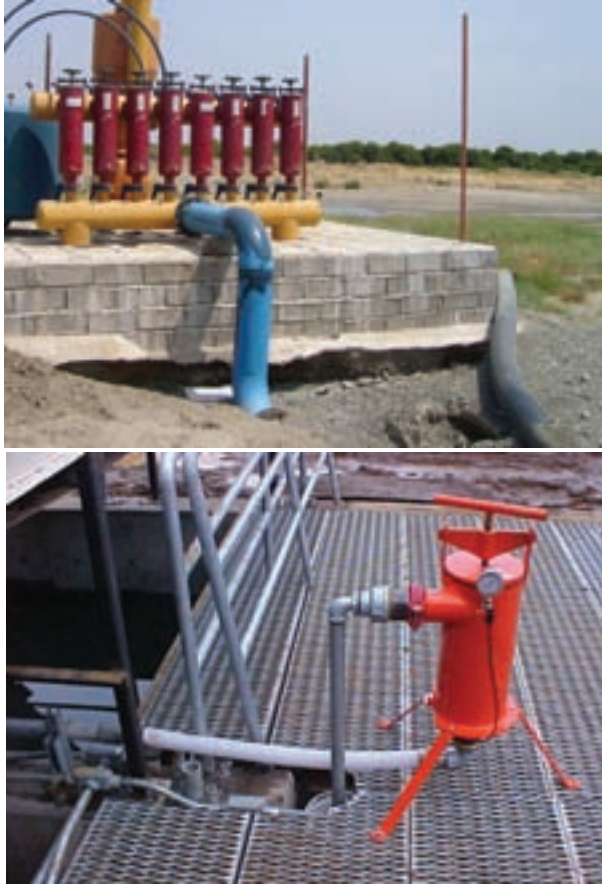
شکل ۲۶-۶- تأسیسات و تشکیلات یک فیلتر توری دار
