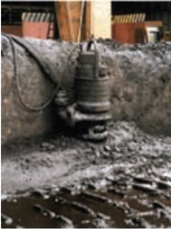
شکل ۹-۵- نصب پمپ کف کش در چاله
